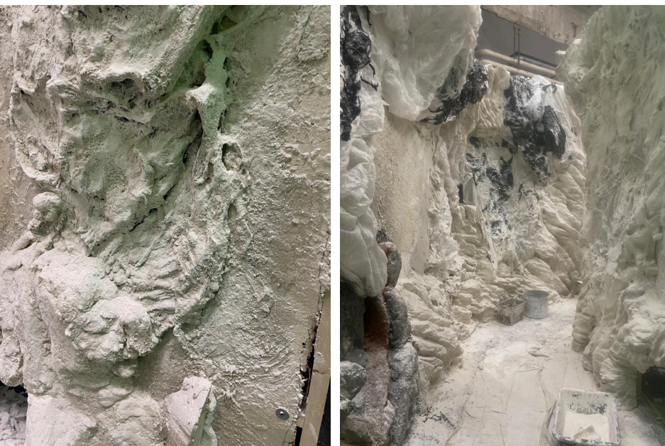
ETAPE 2: ENDUIRE LA STRUCTURE ET PROJETER LE PLÂTRE
